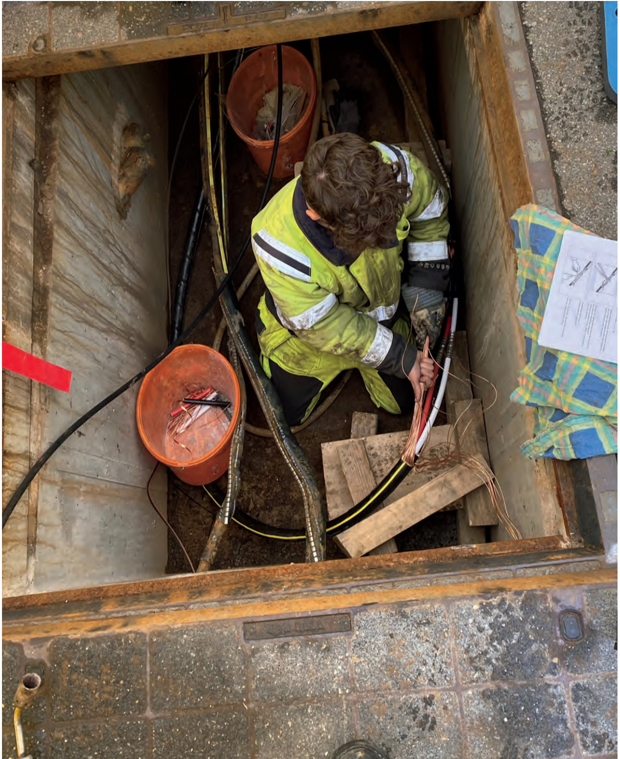
Kabelarbeiten in einem Kabel-Zugsschacht
