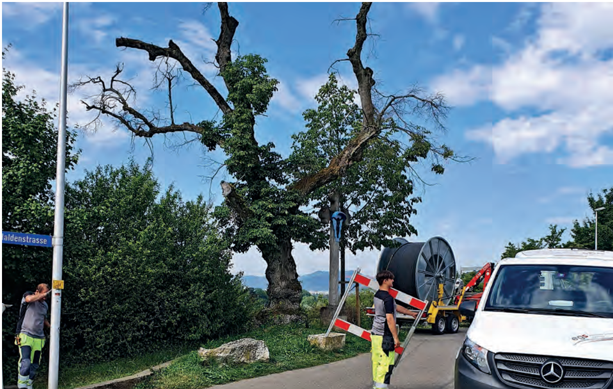
Kabelzug Haldenstrasse US
