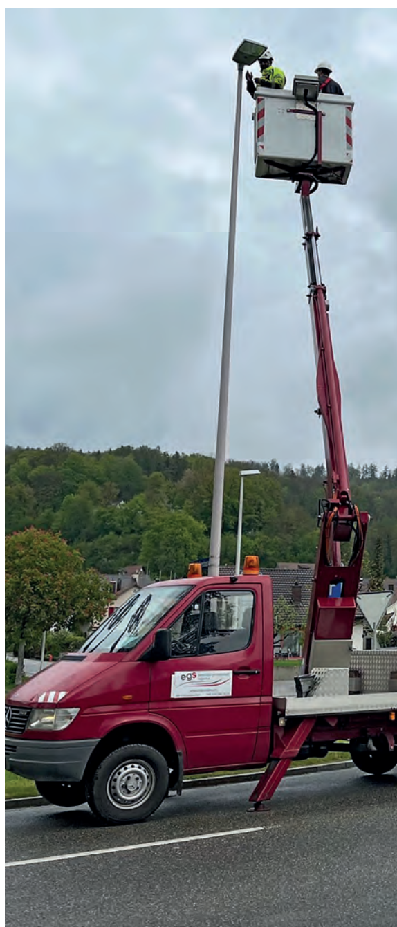
Umrüstung auf LED, Landstrasse US
