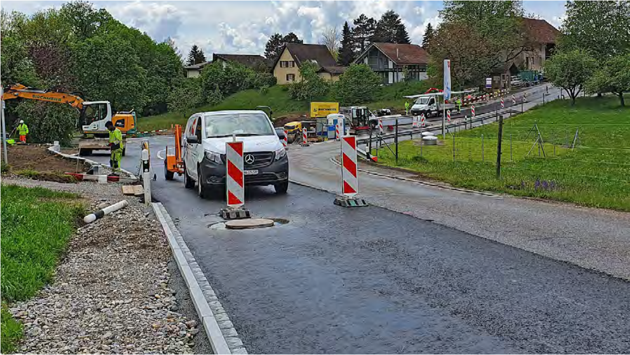
Verzweigung Freienwilerstrasse / Hertensteinstrasse
