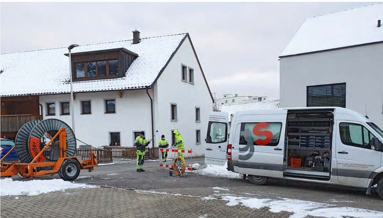
Kabelzug Feldstrasse, Obersiggenthal
