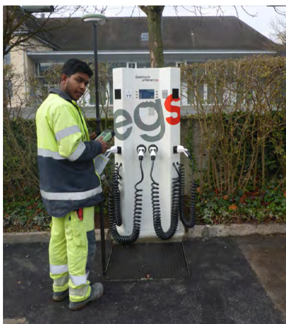
Einmessung der Ladestation beim Gemeindehaus Obersiggenthal
