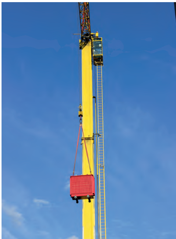
Umbau TS Lochmatte
