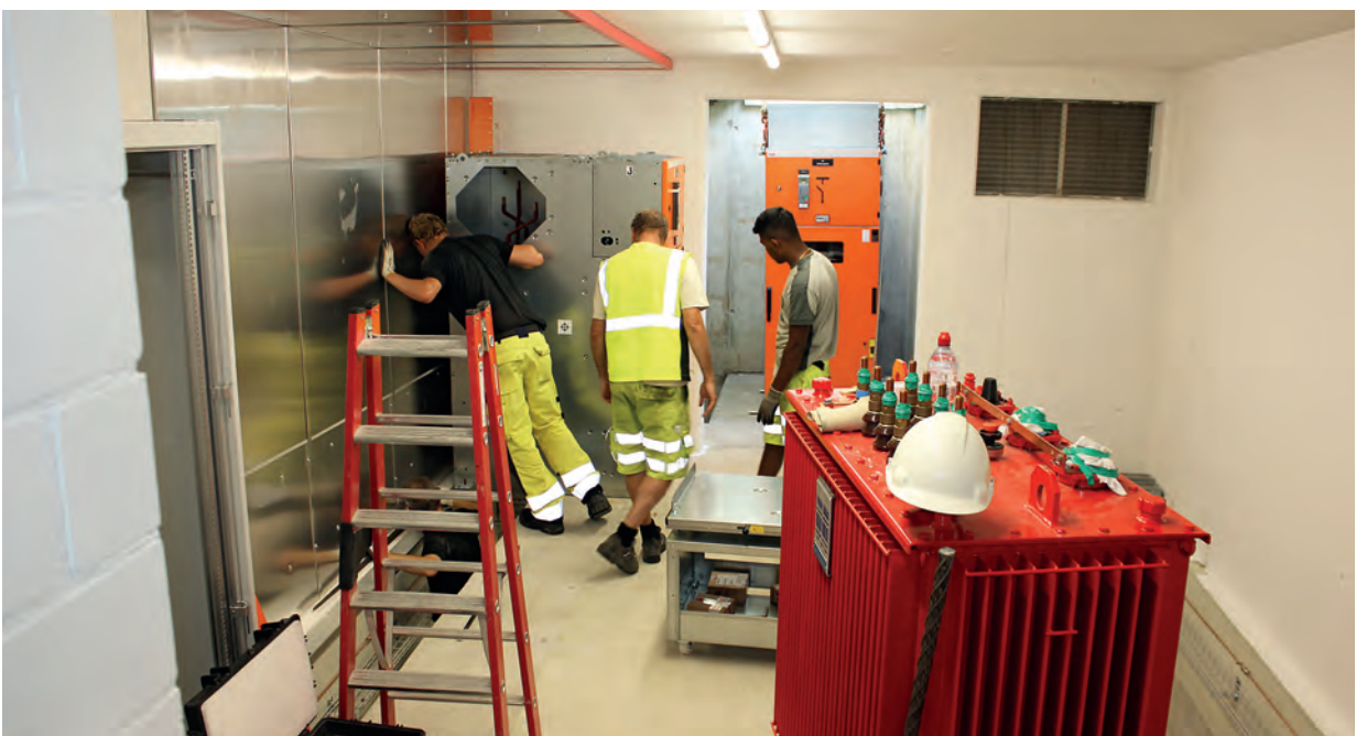
Umbau TS Lochmatte
