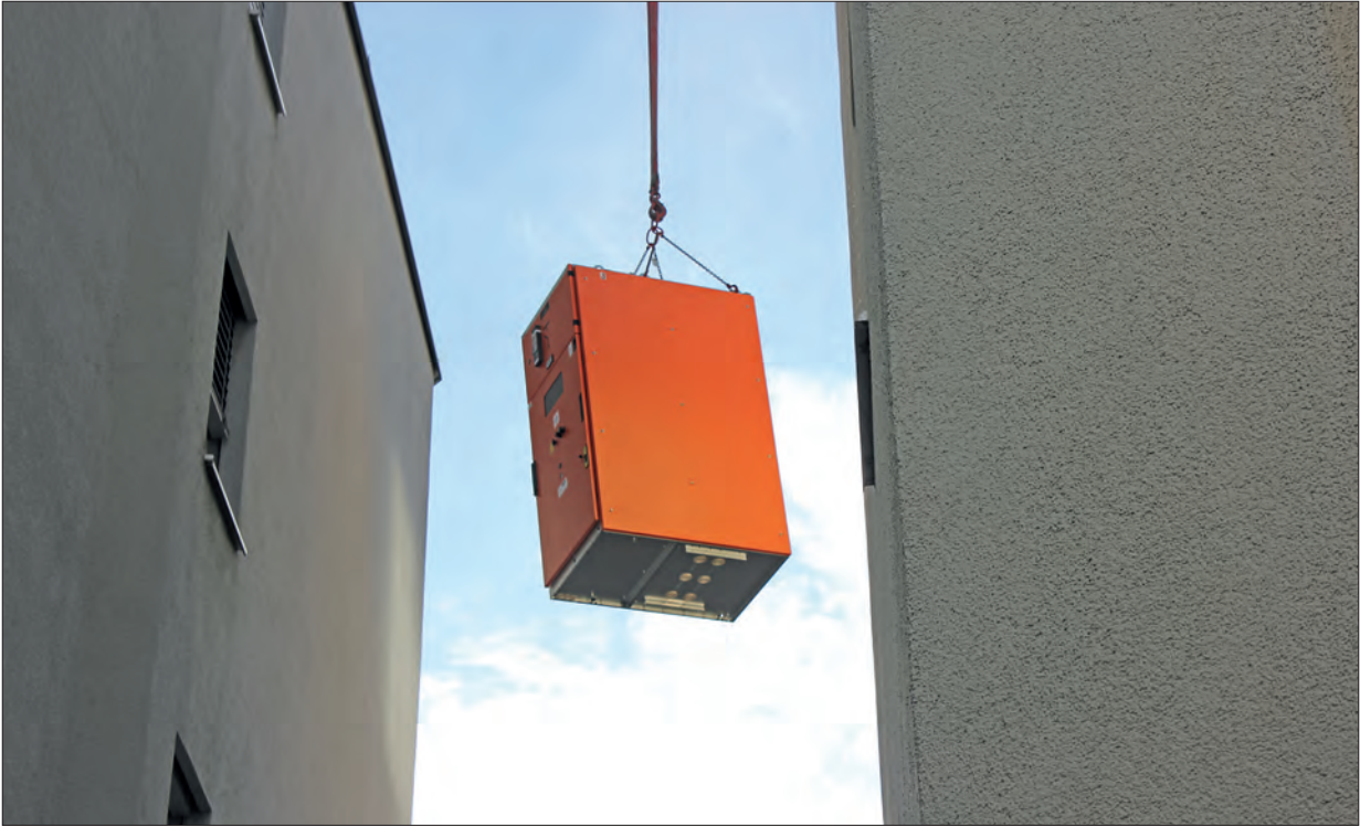
Umbau TS Lochmatte
