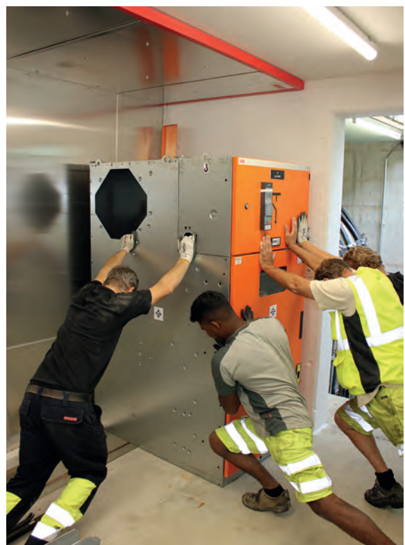
Umbau TS Lochmatte
