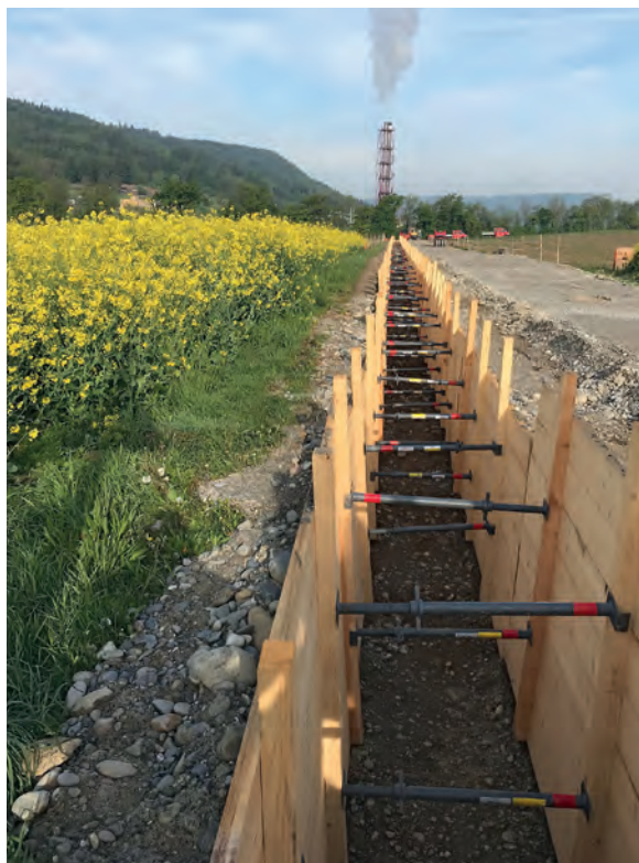
Graben SIBANO mit Sicht auf KVA Turgi
